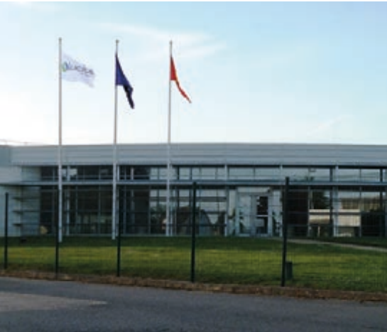
Usine de Barentin (France)
