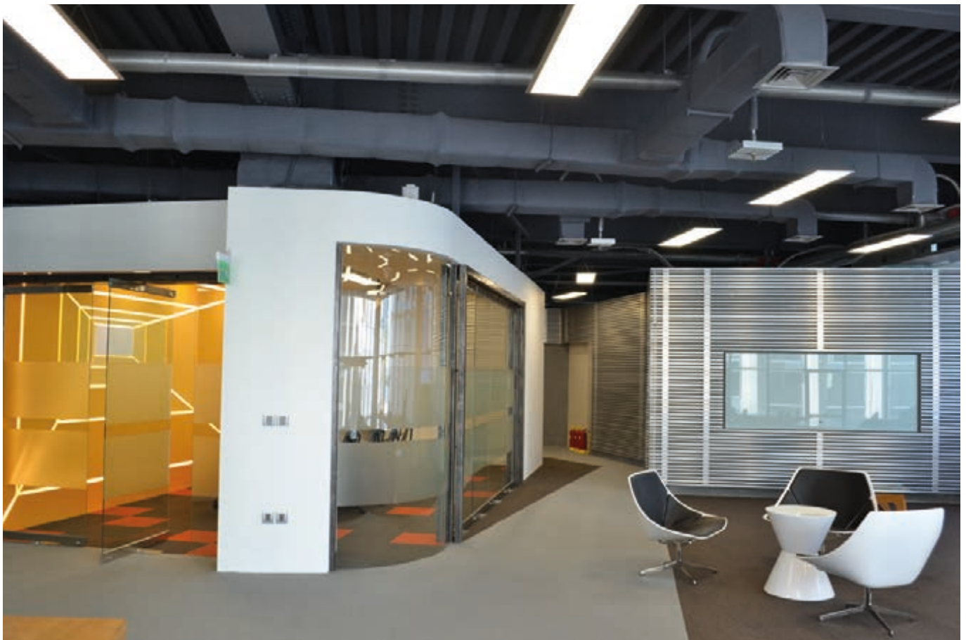
Schneider Electric, Ulaanbaatar (Mongolie)
